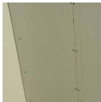
Avvitatura delle lastre solo sui montanti
