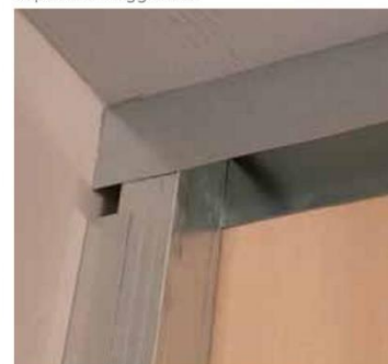
Sigillatura dei giunti perimetrali con mastice acrilico verniciabile
