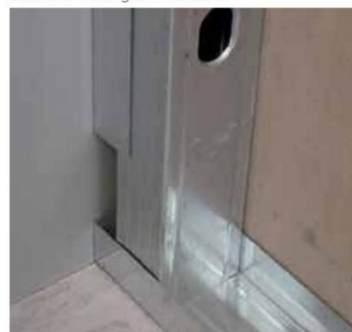
Avvitatura delle lastre solo sui montanti
